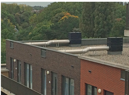
Versleping toevoerkanaal naar de gevel. Foto: Nieman Raadgevende Ingenieurs.
